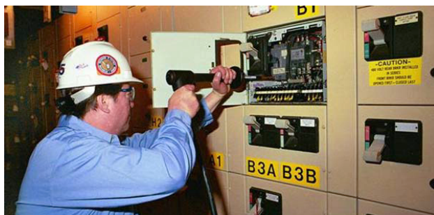
Test de disjoncteur moulé avec le HCP2000
